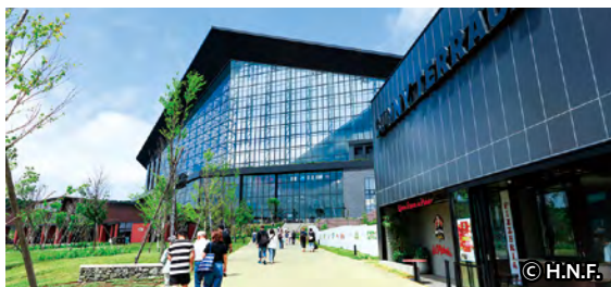
SUNNY TERRACE(サニーテラス)
