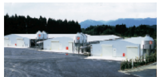
鶏舎の内部（写真上）と外観（写真下）
