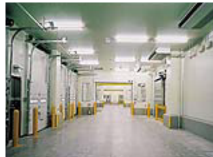
冷蔵庫前の荷捌場
