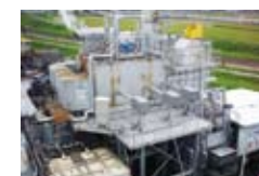
焼却炉廃熱の利用
