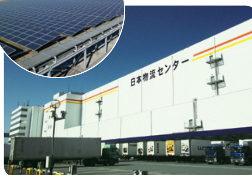
東京事業所と屋上に設置される太陽光パネル
