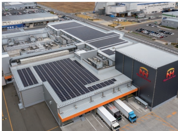
食肉加工品・エキス調味料の製造・販売を担う 日本ビューアフード(株)伊勢崎プラントの太陽光発電設備
