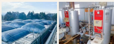
家畜排せつ物をメタン発酵させボイラー燃料化
