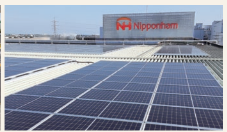
日本ハムファクトリー(株)静岡工場
