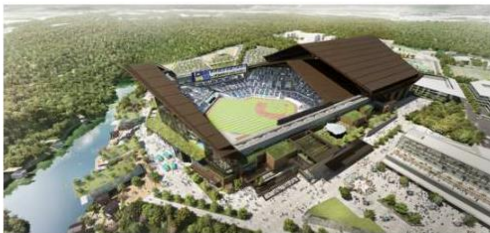
天然芝フィールドを実現する開閉式屋根
