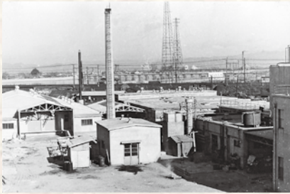
年間生産能力は2,400トンの大阪工場（現在の小野工場は同1万トン）。
