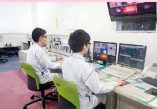
<設備管理センター(タービン建屋2階)> 24時間体制で設備を監視。数値を見ながらボイラーに送る空気や鶏ふんの量を調整。
