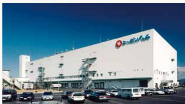
日本ハムファクトリー(株)茨城工場(茨城県筑西市)
