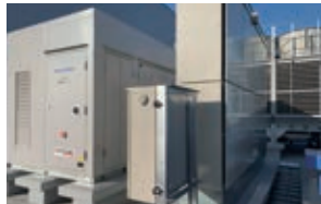
日本デイリーネット(株) 名古屋第二センター ノンフロン冷蔵冷凍装置
