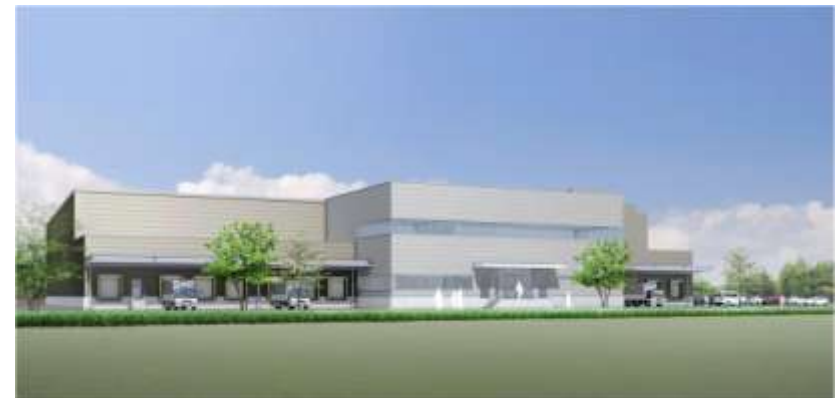
関西工場完成図イメージ
