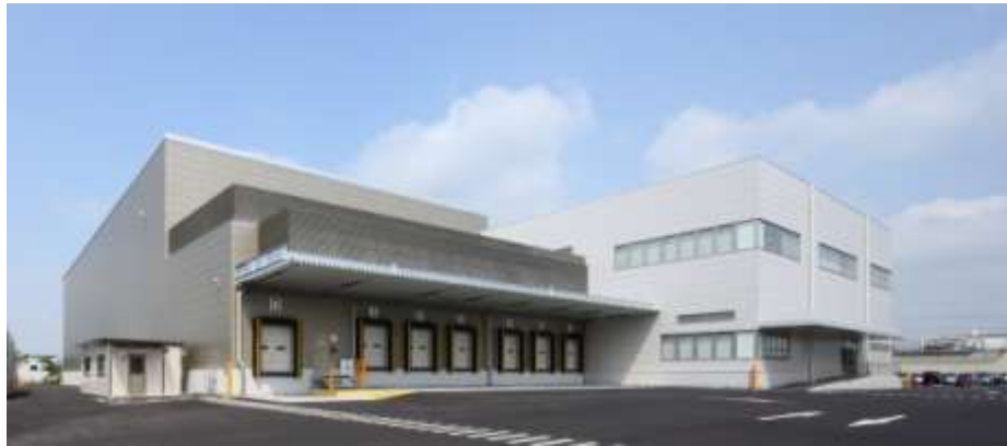
関西工場（2014年6月竣工）
