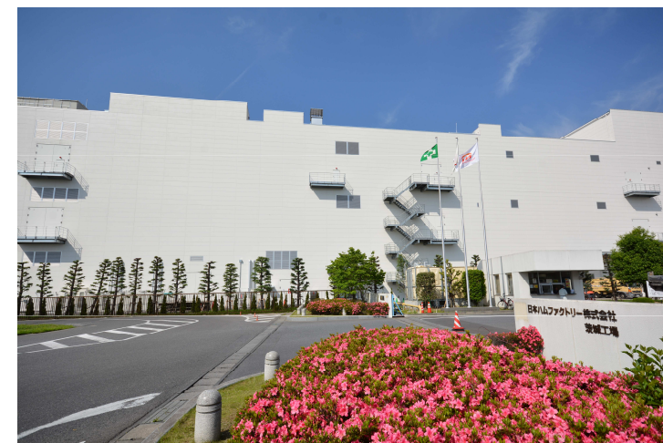
写真：茨城工場新棟
