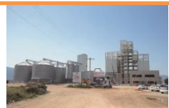
上期より稼働開始した 新飼料工場
